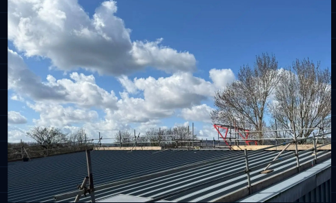
Edge protection + array
